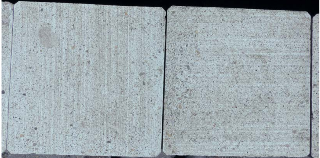
Abb.59 Zustand der Versuchsplatten 7.1 und 7.2 im Frühjahr 2019
