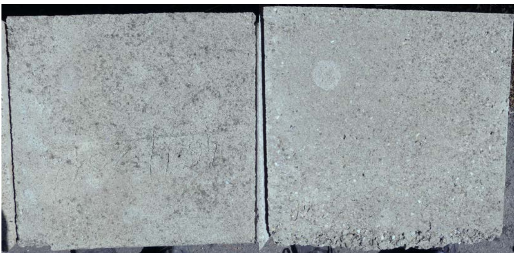
Abb.64 Zustand der Versuchsplatten 13 und 14 im Frühjahr 2019
