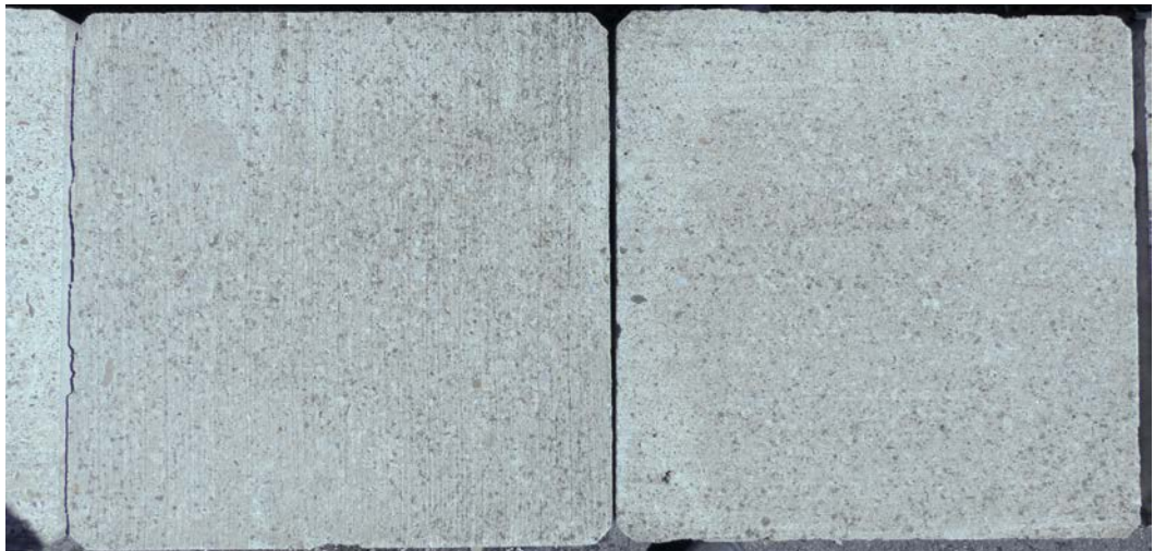
Abb.54 Zustand der Versuchsplatten 2.1 und 2.2 im Frühjahr 2019
