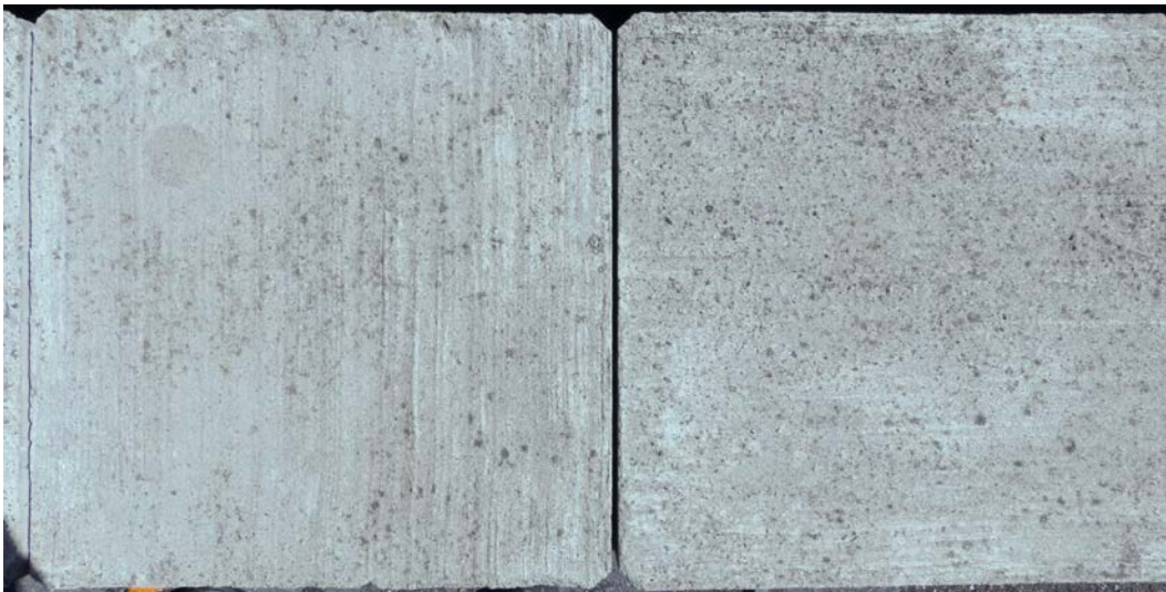
Abb.63 Zustand der Versuchsplatten 12.1 und 12.2 im Frühjahr 2019
